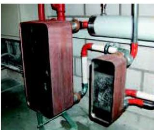
Wenn die Wärme unmittelbar verwendet werden kann oder eine Systemtrennung erforderlich ist, wird meistens mit Plattenwärmetauschern gearbeitet. Diese werden im Gegenstromprinzip betrieben.
