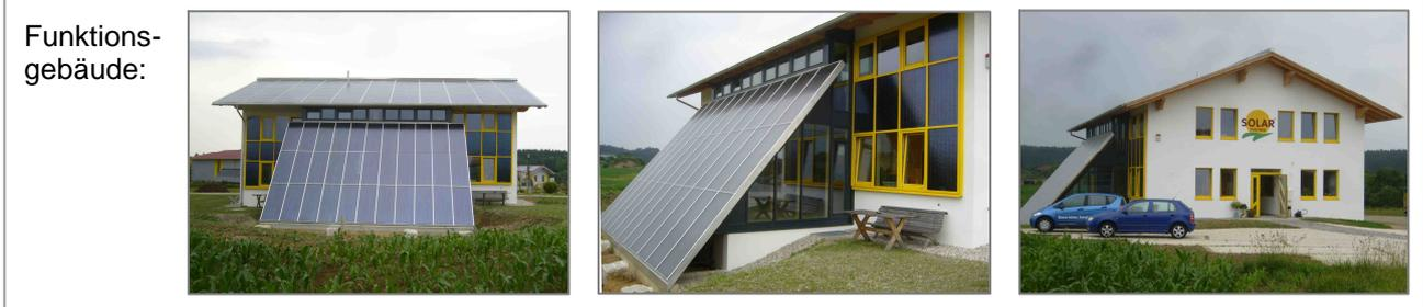
**Lösung 2:** angehobene Montage der Kollektoren
