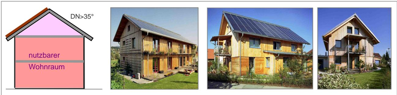
Bild1 : die der Sonne zugewandte Traufseite ist doppelt so lang wie die Giebelseiten und bietet Platz für große Kollektor- und Fensterflächen. Die Photovoltaikanlage ist in beiden Häusern mittig in die Solarfläche integriert. Dachvorsprung und Balkon werden als konstruktive Verschattungselemente genutzt.
