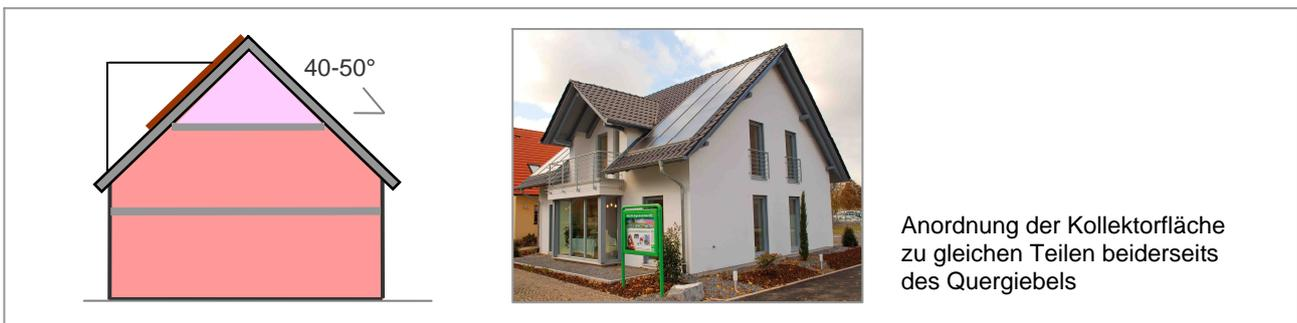
Haustyp 3: asymmetrisches Satteldach, dachintegrierte Solarfläche
