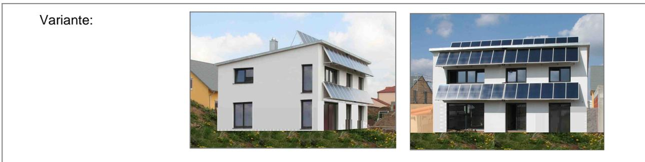
Pultdach, Lösung 3: Schrägdachfläche zwischen Erdgeschoß und Obergeschoß
