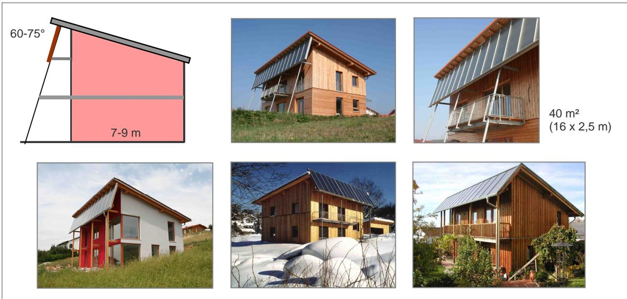
Vorteile: durchgehende Kollektorfläche mit idealer Neigung 35 -50 m² (je nach Geometrie und Hausbreite), einfache Verrohrung ohne Durchdringung der Luftdichtung von Dach oder Wand (Rohrverlegung in Sparren-ebene zum Speicher), Schutz durch das Vordach gegen eindringendes Regenwasser, Kollektor dient als konstruktive Verschattung der Fenster, ebenso der darunter angeordnete Balkon
