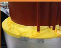
Für Sonnenhäuser mit hohem solaren Deckungsgrad, für welche Wärme über längere Zeit gespeichert werden soll, bieten wir hochisolierte Speicher (20 bis 30 cm) an. In die Speicherisolation wird ein Ballonstoff eingearbeitet, um eine vertikale und horizontale Kammerung zu erreichen. Zudem sind siphonierte Anschlüsse bei solchen Speichern sehr wichtig. Alle diese Massnahmen tragen zu einer verbesserten Schichtung bei.
