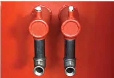
Die **Schwerkraftweiche** ist eine Art automatisches Ventil, das im Rücklauf des bestehenden Heizsystems angeschlossen wird. Weitere Infos dazu in unserer Spezialbroschüre
