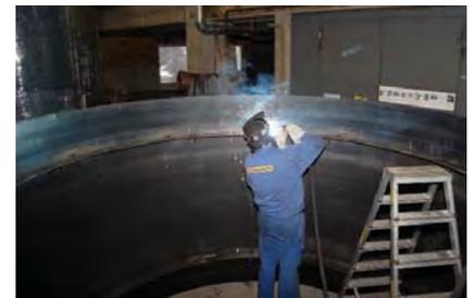
Grosse Speicher und solche mit erhöhtem Betriebsdruck werden mit **Verstärkungsringen** ausgestattet, um eine optimale Stabilität zu gewährleisten
