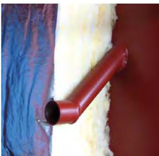
Schräganschlüsse mit internen Strömungsbremsen optimieren die Temperaturschichtung und minimieren die Energieverluste
