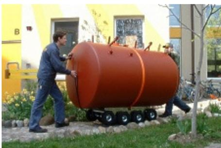
Der Wagen wird in der Regel stehend mit dem Gurt an den Speicher gebunden. Dann kann der Speicher auf die Räder gekippt werden. Der Wagen soll erst wieder entfernt werden, wenn der Speicher steht.
