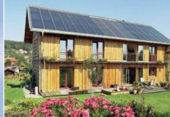
Normwärmebedarf: 8 kW Kollektorfläche: 78 m² Neigung: 35°
